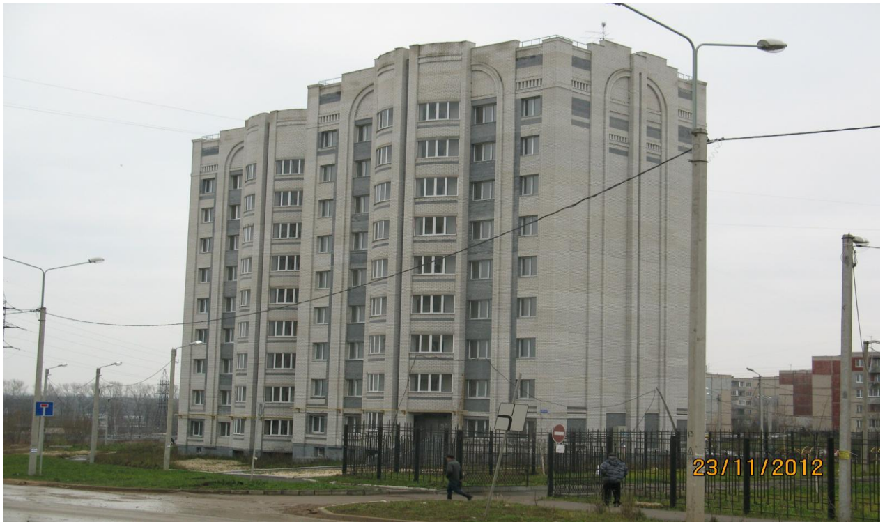
Фото 6. Социальный многоквартирный жилой дом (II очередь) по ул.Фатьянова, д.21, Застройщик – МКУ «Владстройзаказчик»
