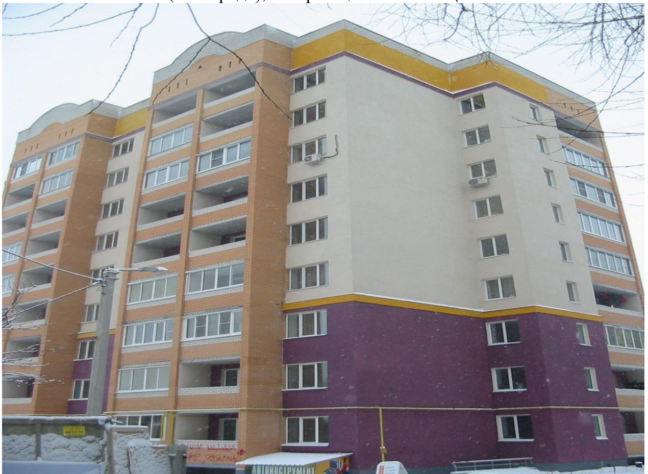
Фото 5. Многоквартирный жилой дом по ул.Ставровской, д.3 Застройщик – ДЗАО УПТК «Владимирагроводстрой»
