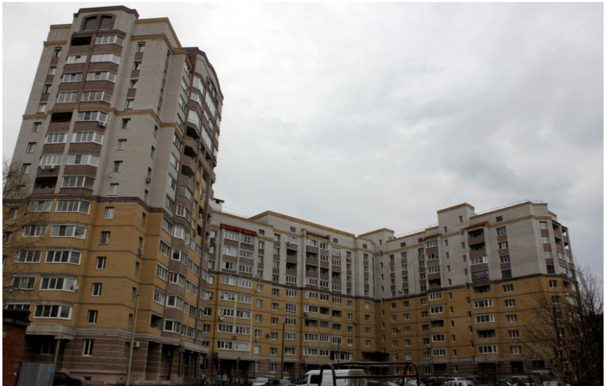
Фото 4. Многоквартирный жилой дом по ул.Студенческой, д.6-д (II очередь), Застройщик – ООО «ЦВС»
