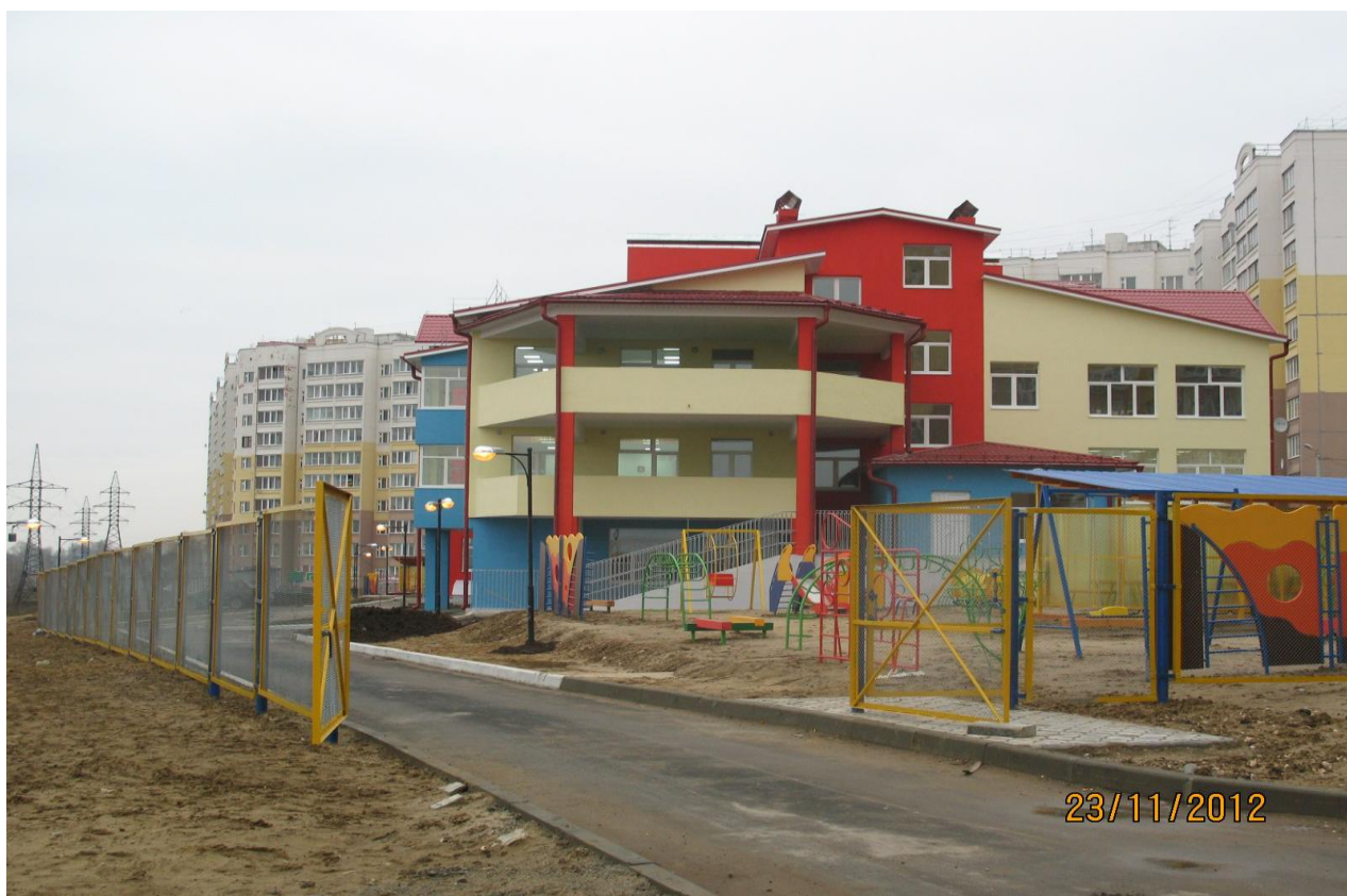
Фото 1. Детский сад на 135 мест в мкр.8-ЮЗ по ул.Фатьянова, д.14 Застройщик – ОАО «Ивановская Домостроительная компания»
