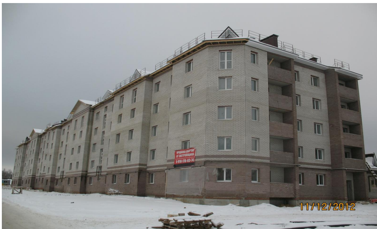
Фото 28. Многоквартирный жилой дом ул.Славная, д.15 Заказчик — ООО «Строй СИТИ»
